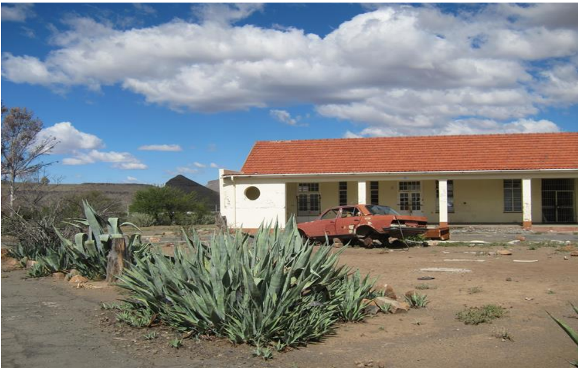
Abb. 4: Zerstörte Gebäudeteile der Tuberkuloseklinik
